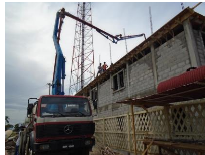
Pouring Veranda Floor
